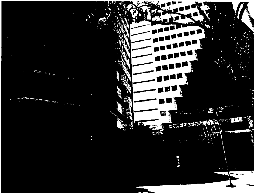
Foto 1: Foto da Fachada da Imóvel onde se localiza o conjunto avaliando
