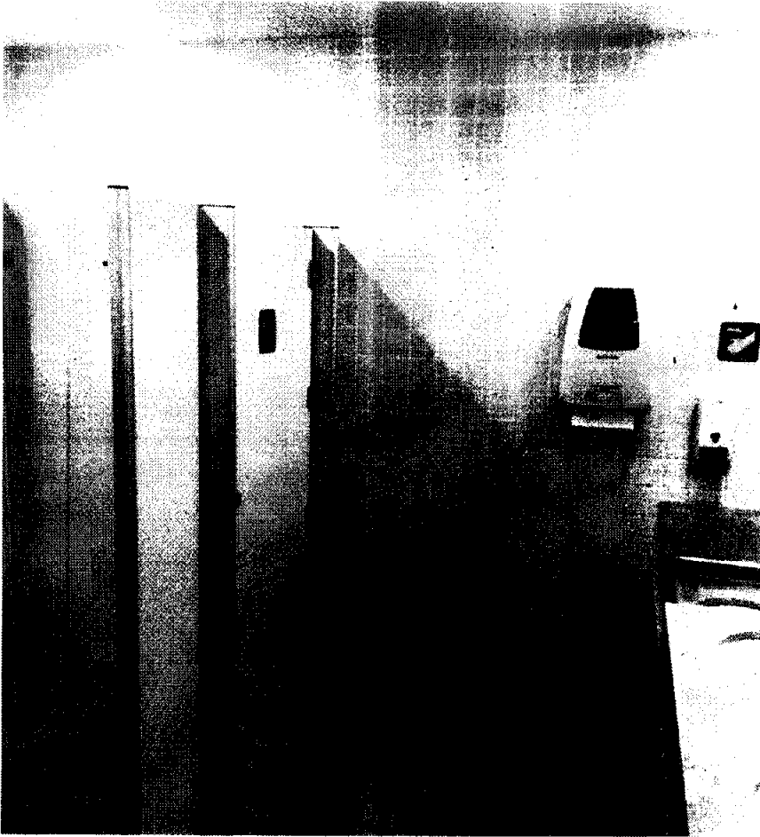
Foto 16: Padrão geral dos banheiros do conjunto comercial 701
