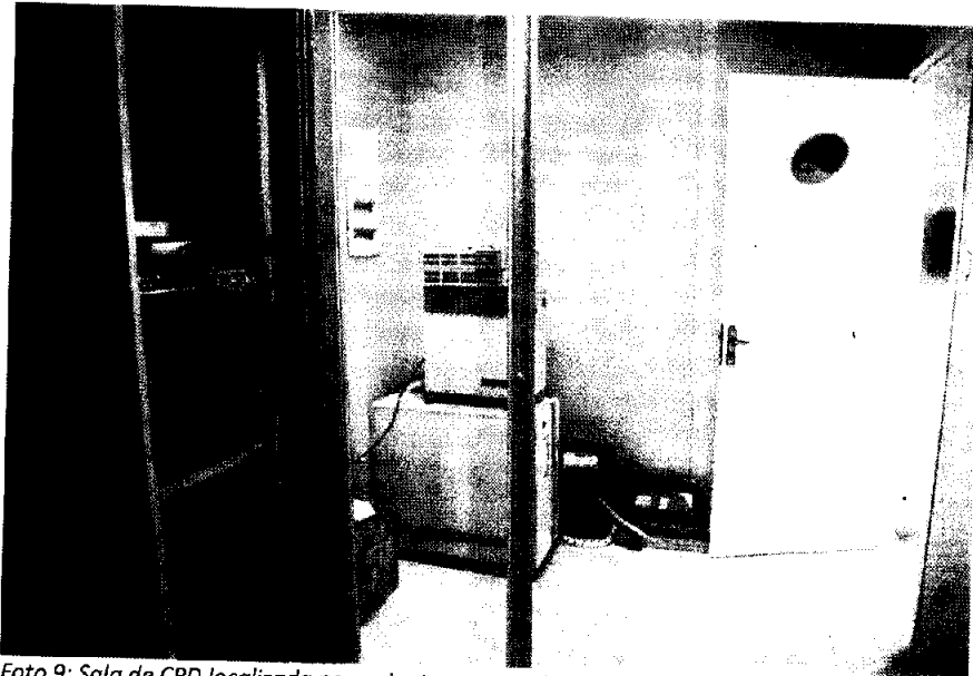
Foto 9: Sala de CPD localizada no conjunto comercial
