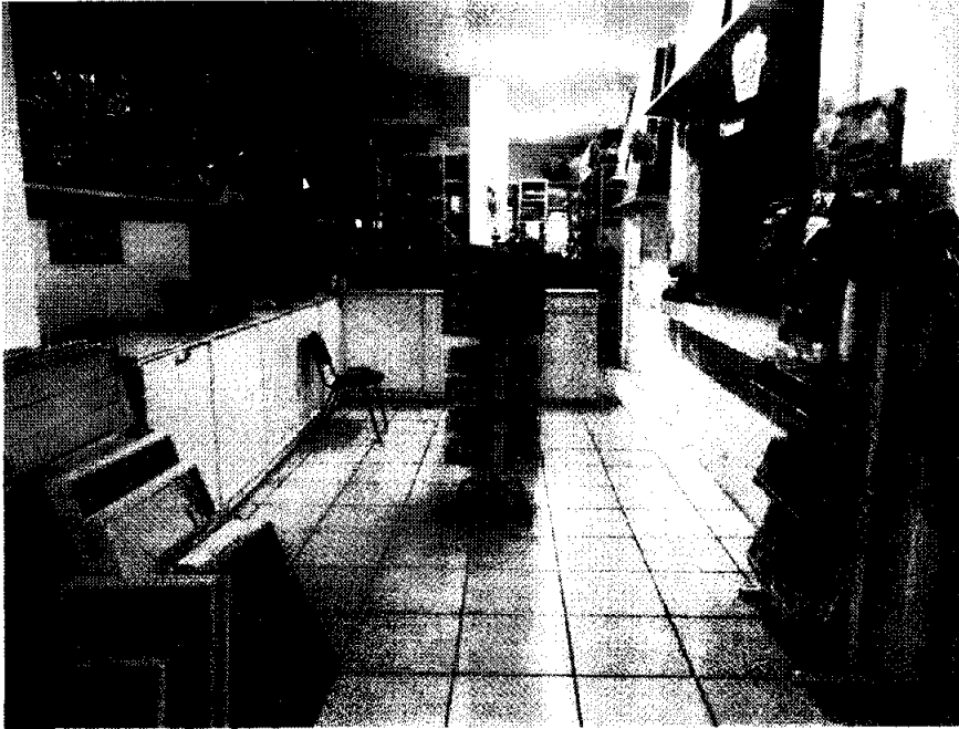
Foto 7: Panorama geral da sobreloja da loja avalianda. Piso em cerâmica, mas sem forro de gesso.
