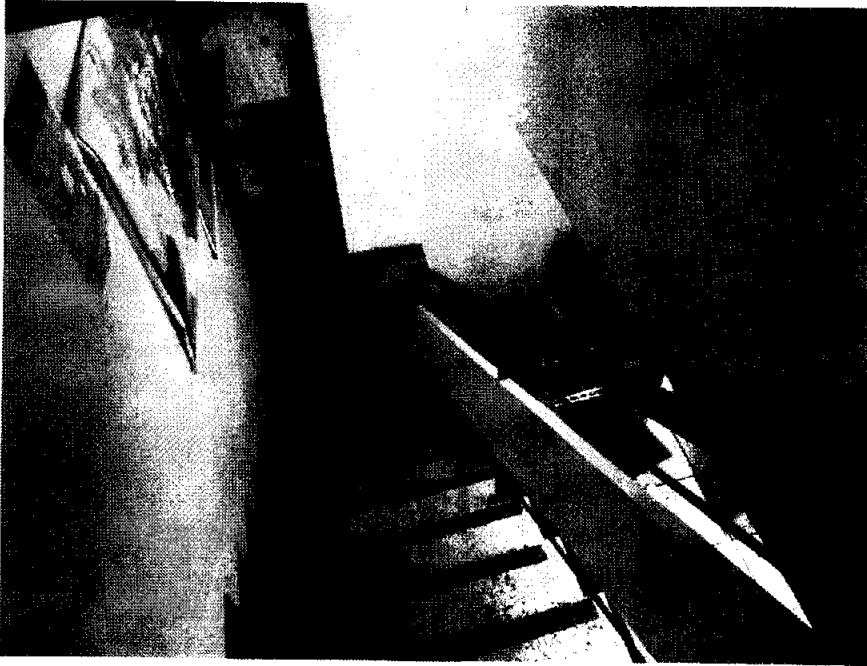
Foto 6: Escada de acesso à sobreloja
