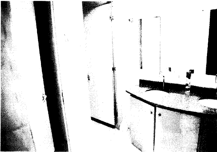
Foto 12: Padrão geral dos banheiros no conjunto comercial
