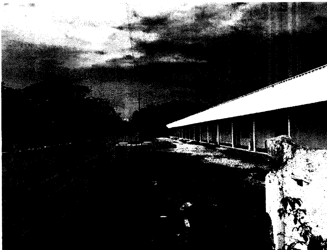
Foto E: Panorama Geral do Terreno no Lado "A"
