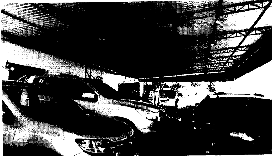
Foto 13: Lateral Direita do Imóvel – Frente para os fundos
