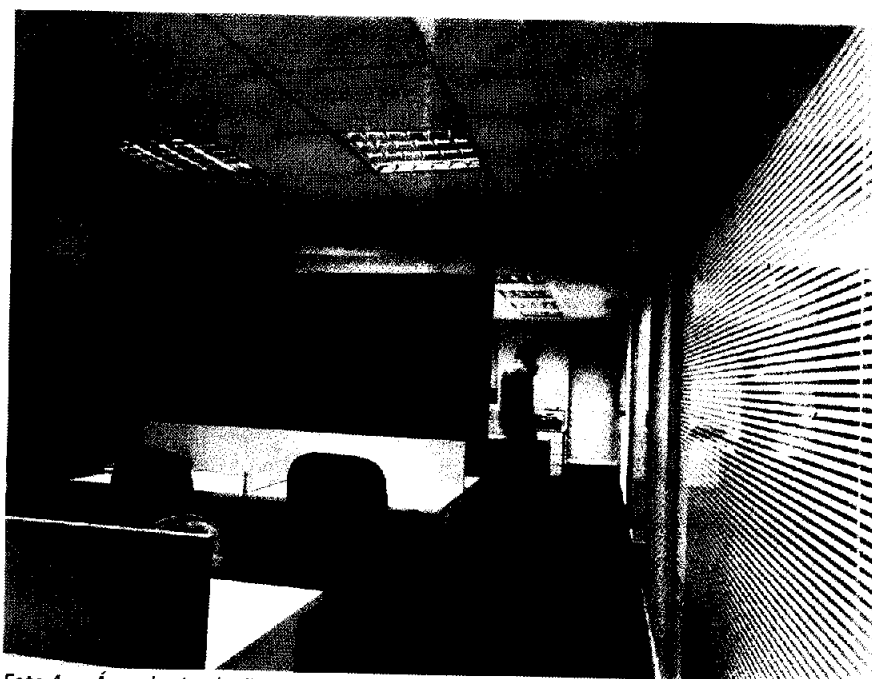
Foto 4: Área de circulação Destaque para o piso em carpete e forro de gesso rebaixado em gesso e placas Algumas divisórias em vidro para compartimentalização de ambientes
