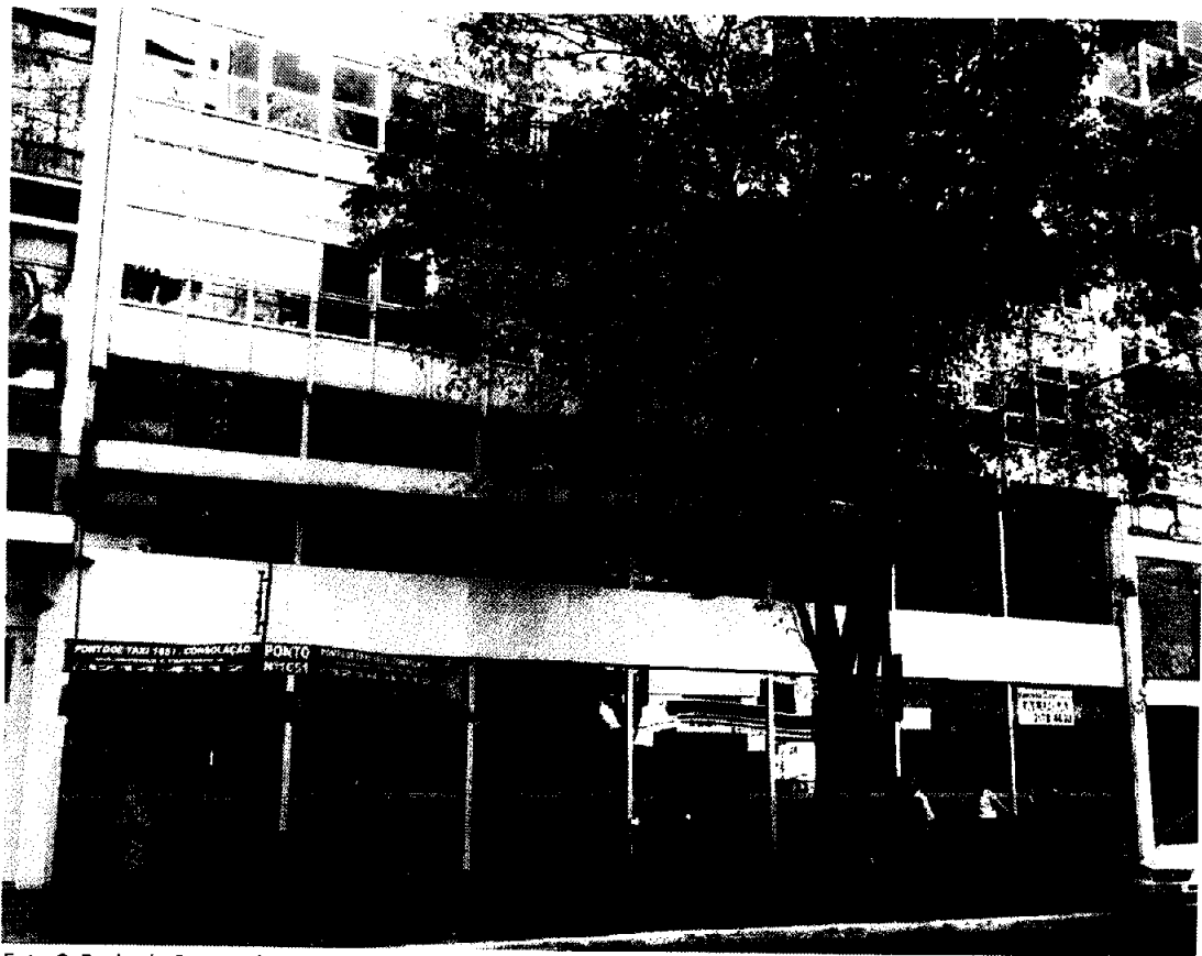
Foto C: Fachada Principal da Edificação onde se localizam os conjuntos comerciais
