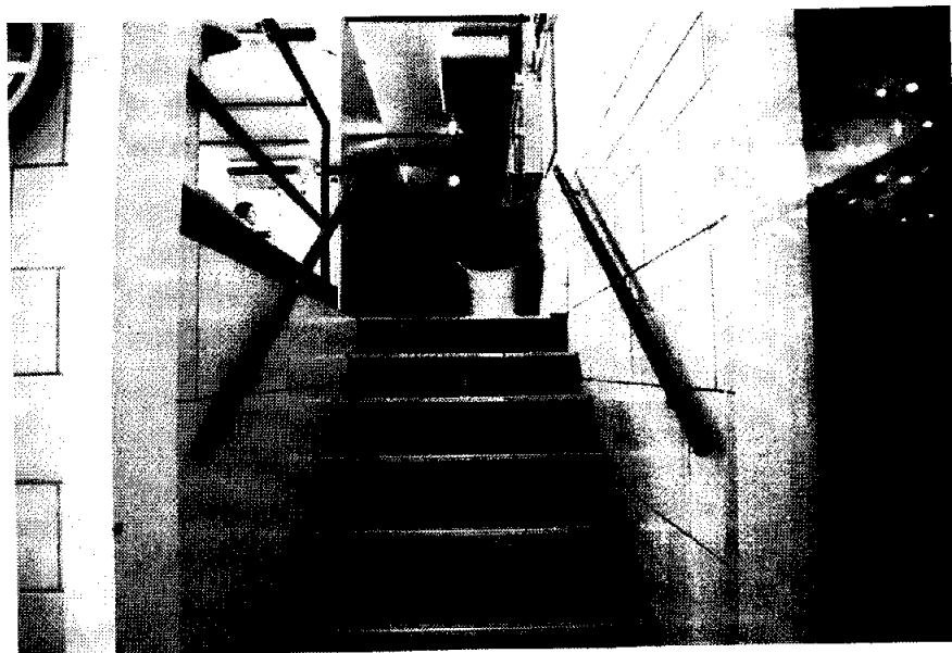
Foto 4: Escada de acesso ao segundo piso da loja avalianda
