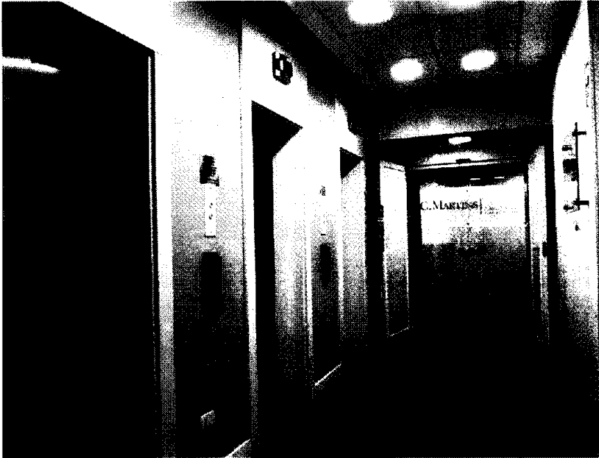
Foto 10: Hall de Circulação dos Elevadores no Conjunto 61
