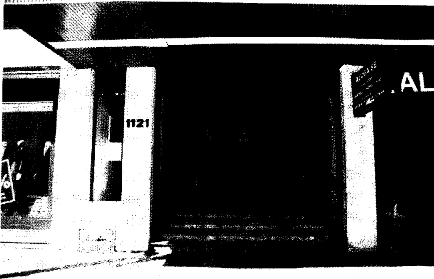
Foto 1: Fachada Principal da Edificação onde se localizam os conjuntos comerciais
