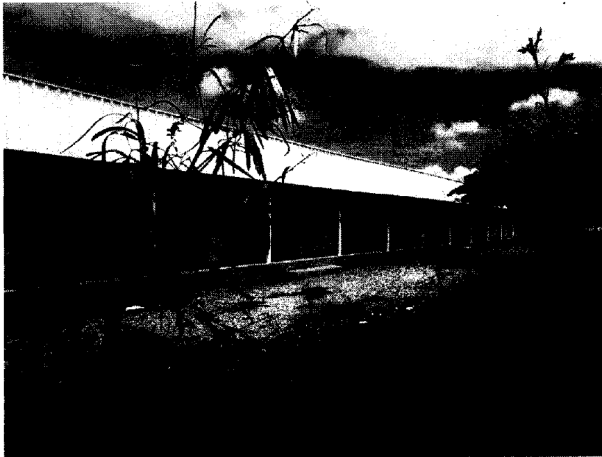
Foto 4: Foto do terreno onde se localiza a parte "A" do terreno Galpão sendo utilizado para salas de aula em bom estado de conservação.
