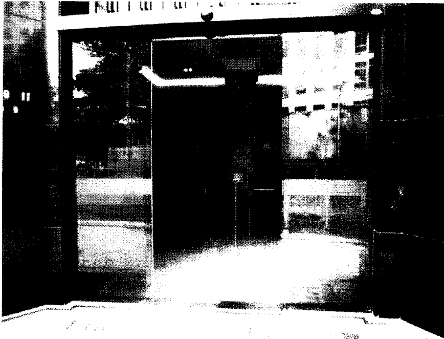
Foto 1: Foto do Hall de Entrada da Edificação onde se encontra o imóvel avaliando
