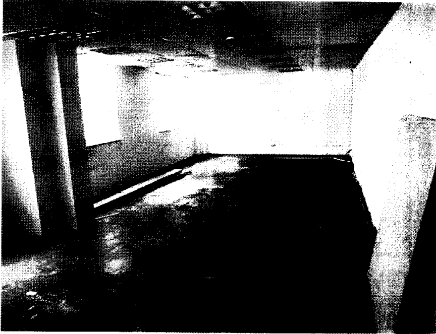
Foto 3: Salão desocupado no conjunto comercial avaliando
