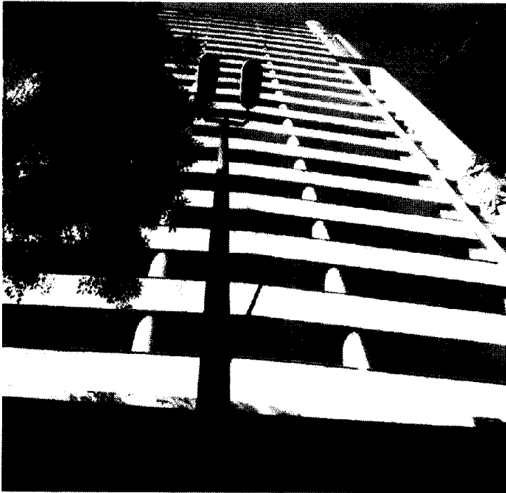
Foto B: Fachada da Edificação na Av. Afonso Pena nº 867
