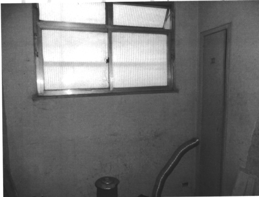
Foto 17: Foto do quarto de empregada em reforma
