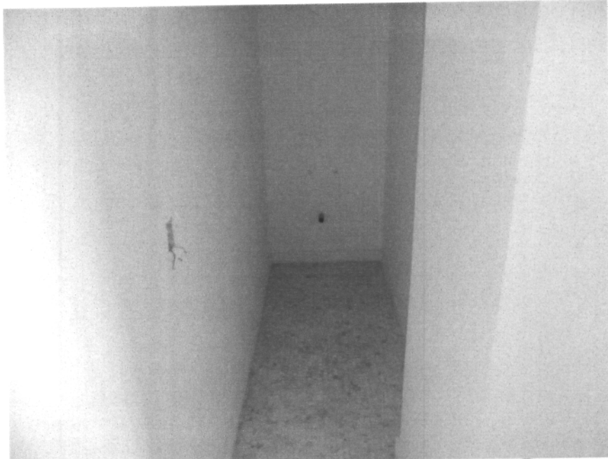
Foto 14: Foto do lavabo em reforma
