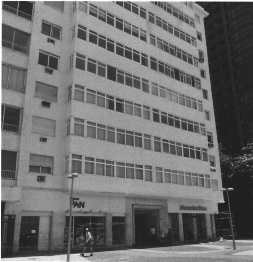
Foto 1: Foto da Fachada do Imóvel na Av. Atlântica
