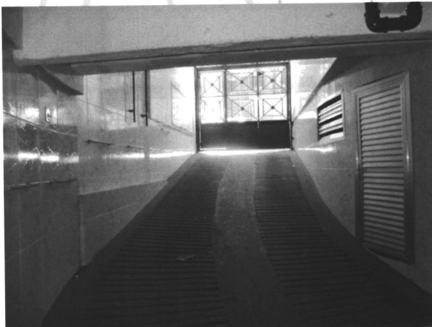
Foto 19: Rampa de acesso dos veículos da edificação
