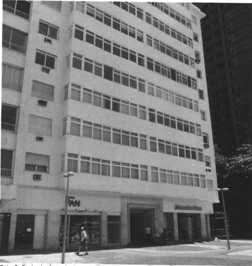
Foto B: Fachada do Imóvel na Av. Atlântica 1536 – Edifício Jordan
