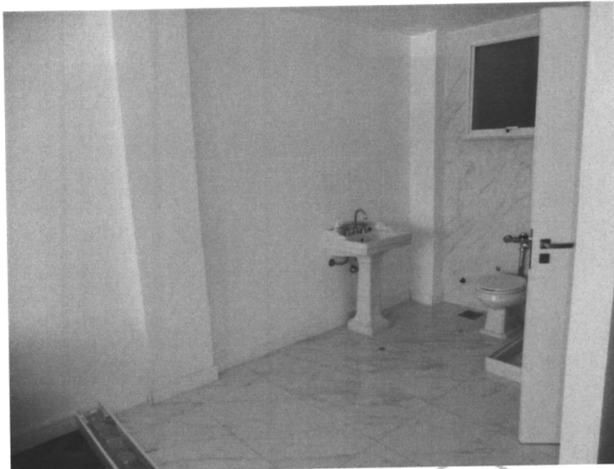
Foto 7: Foto do banheiro da suíte principal em reforma
