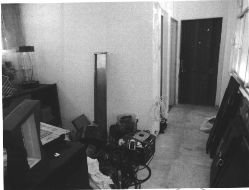
Foto 16: Foto da cozinha em reforma, com acesso para a área de serviço
