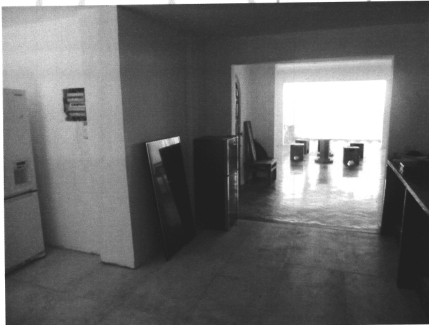
Foto 15: Foto da Cozinha visualizando a sala de estar (em reforma)
