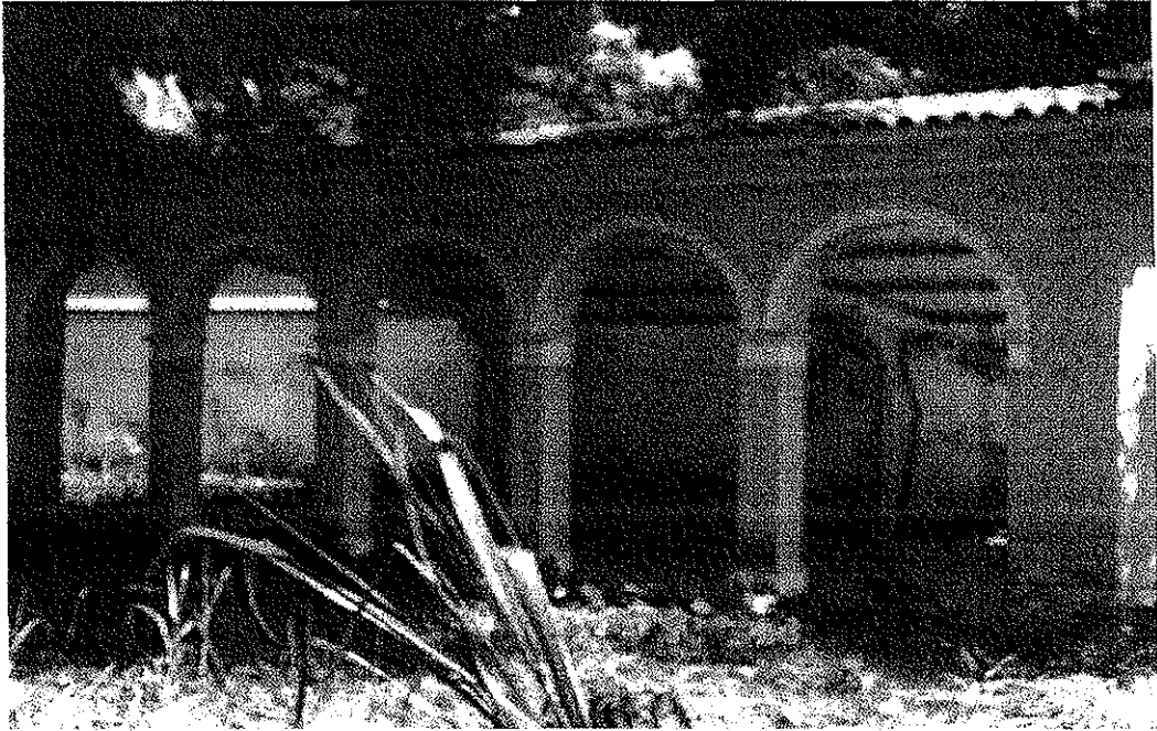
Detalhes internos. Área coberta de garagem, aos fundos.
