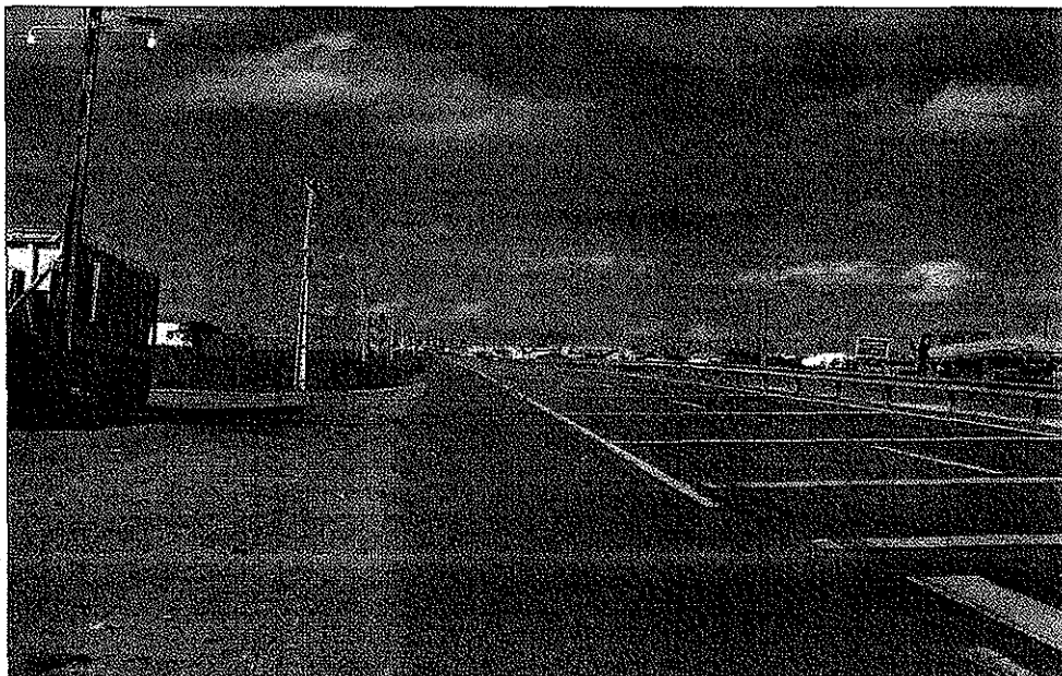
Rodovia AL-101 – Sul, acesso aos terrenos.
