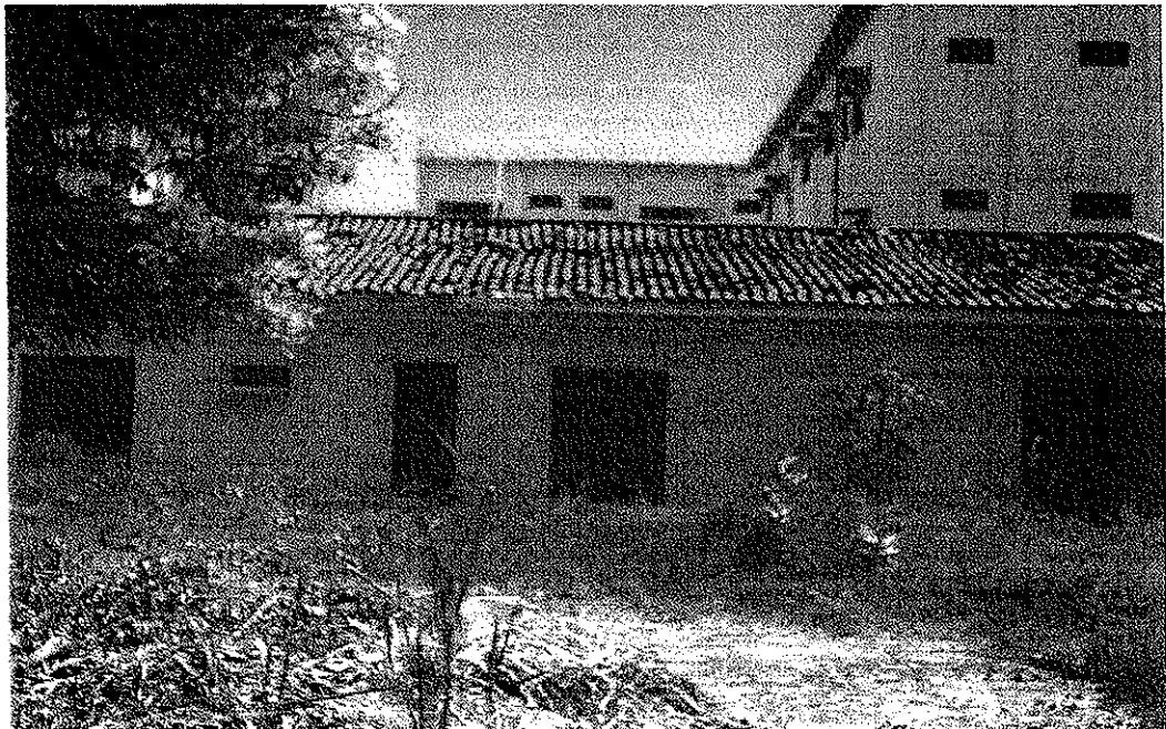
Detalhes internos. Depósitos e salas – fundos.
