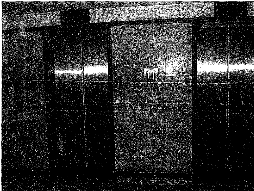
HALL DOS ELEVADORES
