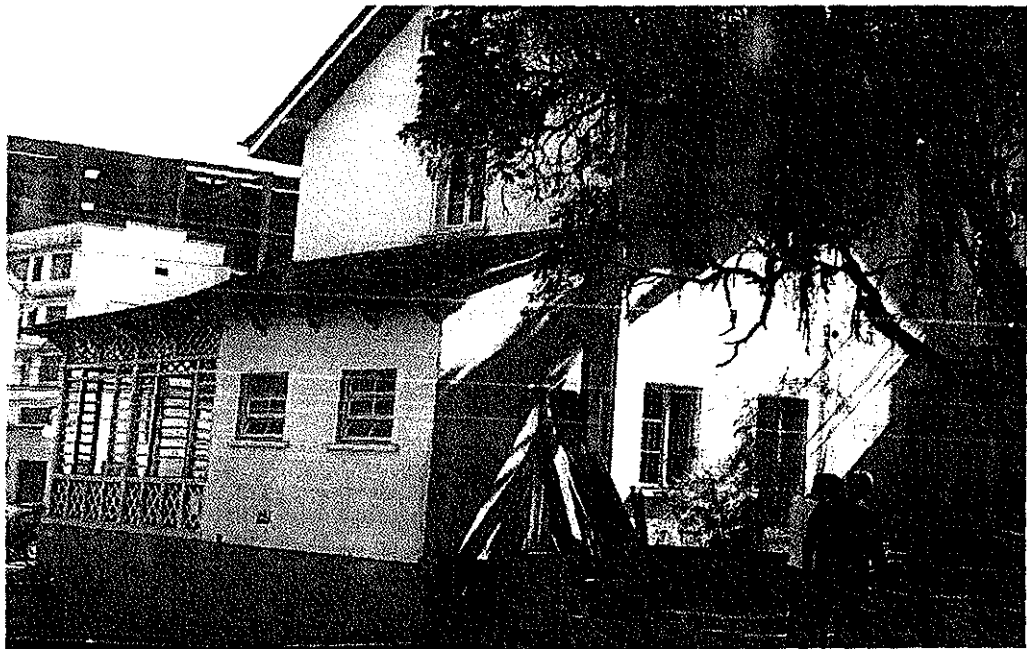
Vista lateral e fundos o imóvel.
