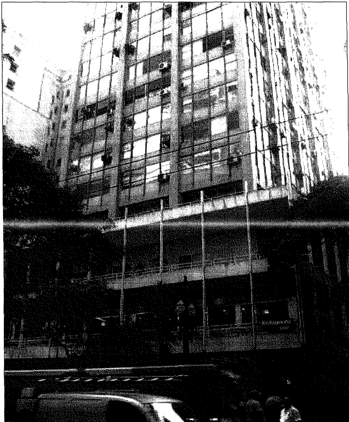
EDIFÍCIO METRÓPOLE – AVENIDA SÃO LUIS, 153 – REPÚBLICA – SÃO PAULO/SP
