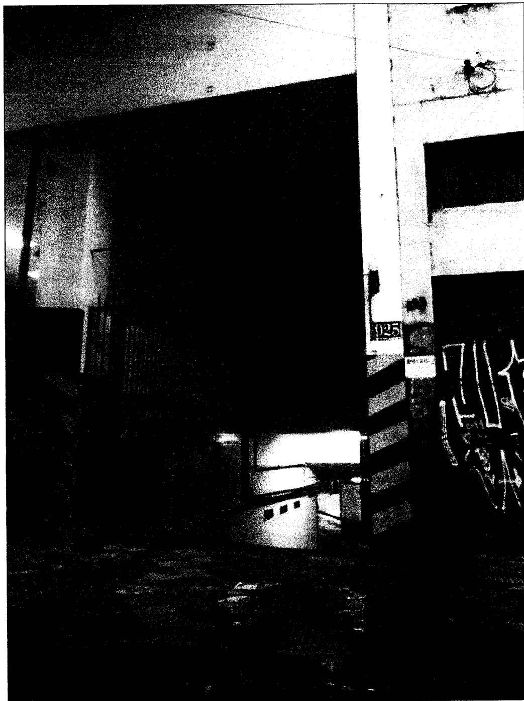
AV. IPIRANGA, 925 – ACESSO GARAGEM EDIFÍCIO CONJUNTO CINERAMA
