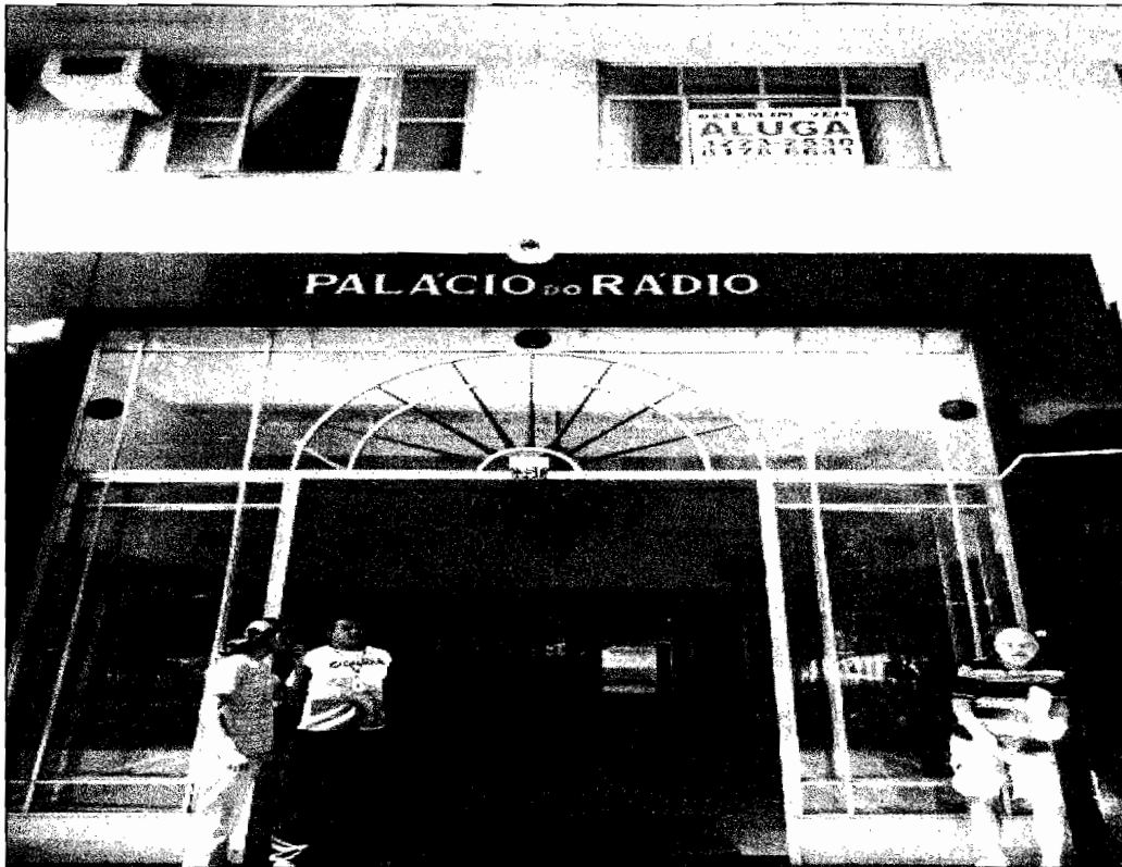
DETALHE DA FACHADA DO ACESSO PRINCIPAL DO EDIFÍCIO
