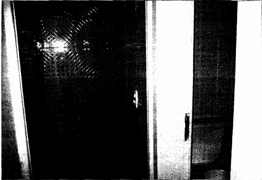
Vista interna. Subsolo (banheiros).
