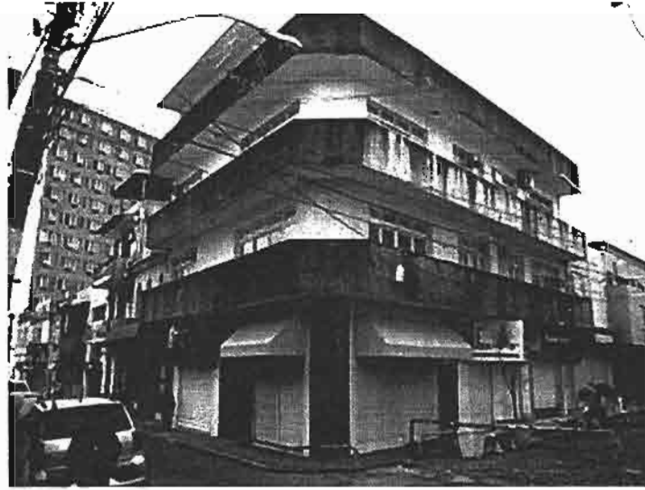
1- Imagem do imóvel feita da rua Cel Paiva
