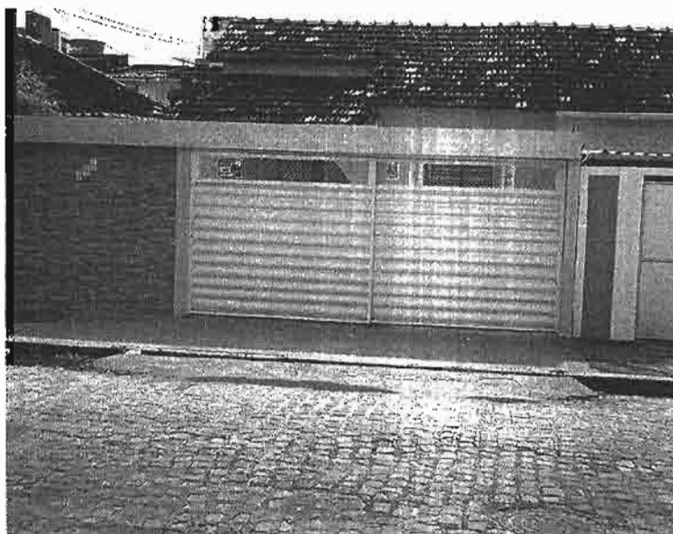
2-Imóvel após a construção de portão – outubro 2014
