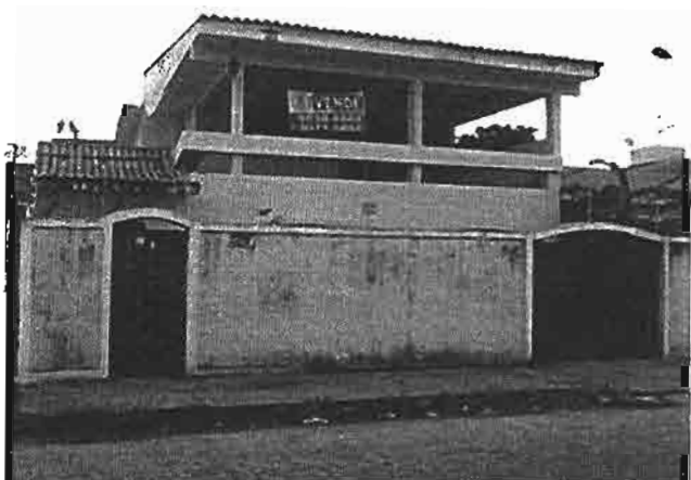
CASA , DOIS PAVIMENTOS, SENDO PAVIMENTO TÉRREO: GARAGEM, 01 SAL...
