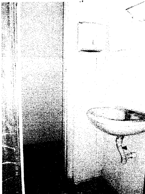
Foto 19: Foto do banheiro do conjunto 514
