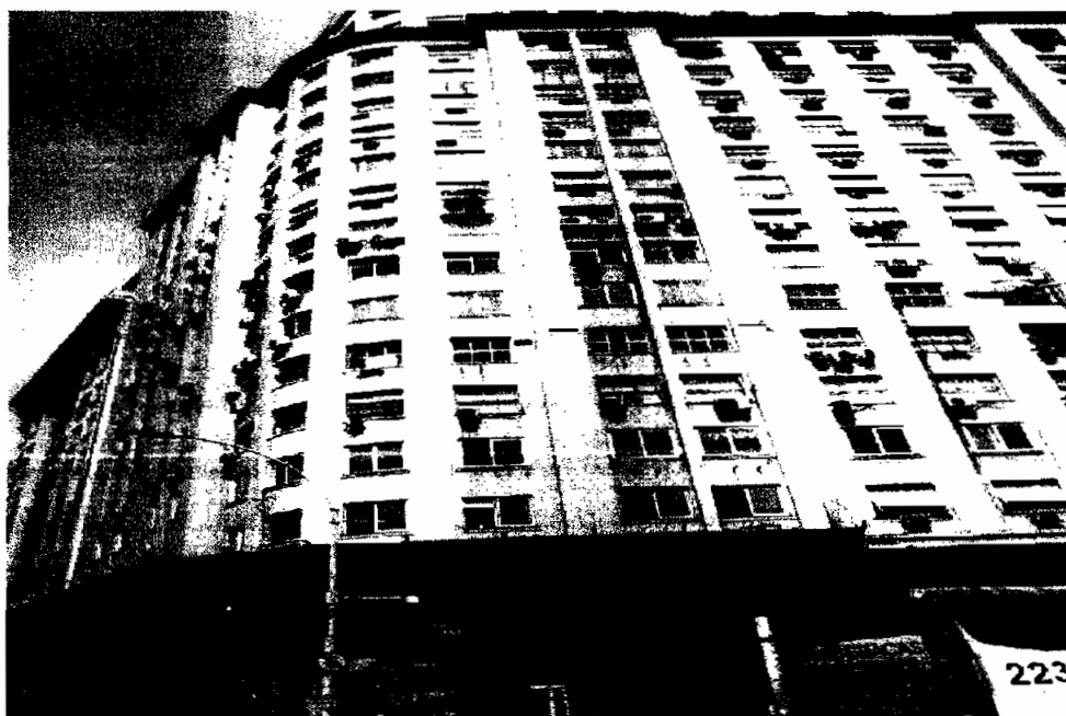
Edifício Civitas B – Rua México, nº 11 – Centro/RJ.
