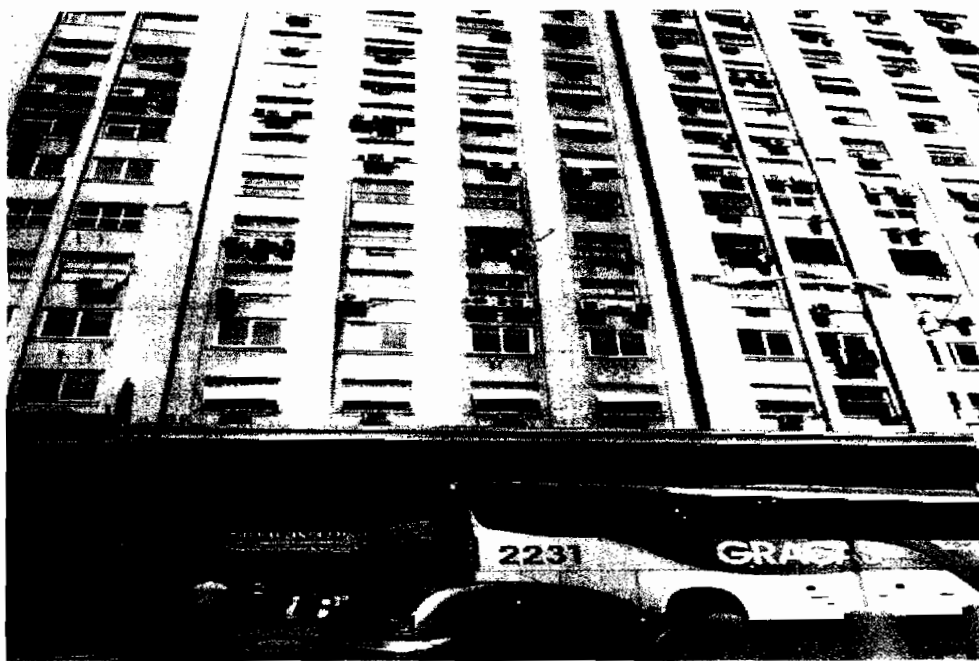
Edifício Civitas B – Rua México, nº 11 – Centro/RJ.
